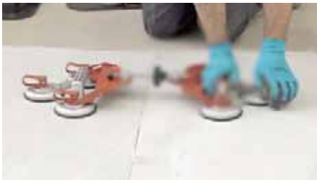
Dispositivo accosta-lastre / Verlegehilfe zur Justierung der Platten
