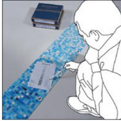
Der Farbverlauf wird durch die Abfolge verschiedener, farblich abgestufter Blätter (Module) erzielt. Jedes Modul besteht aus acht Blättern, die von 1 bis 8, jeweils vom hellsten bis zum dunkelsten, nummeriert sind.
